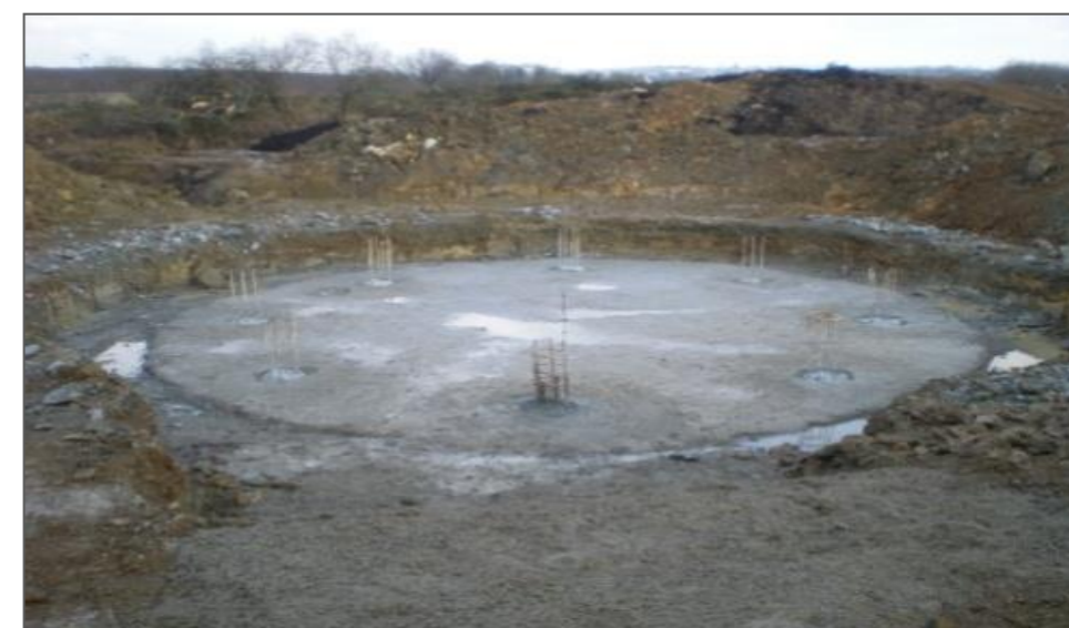
Figure 262 : Illustrations photographiques des étapes de construction d'une fondation d'éolienne
