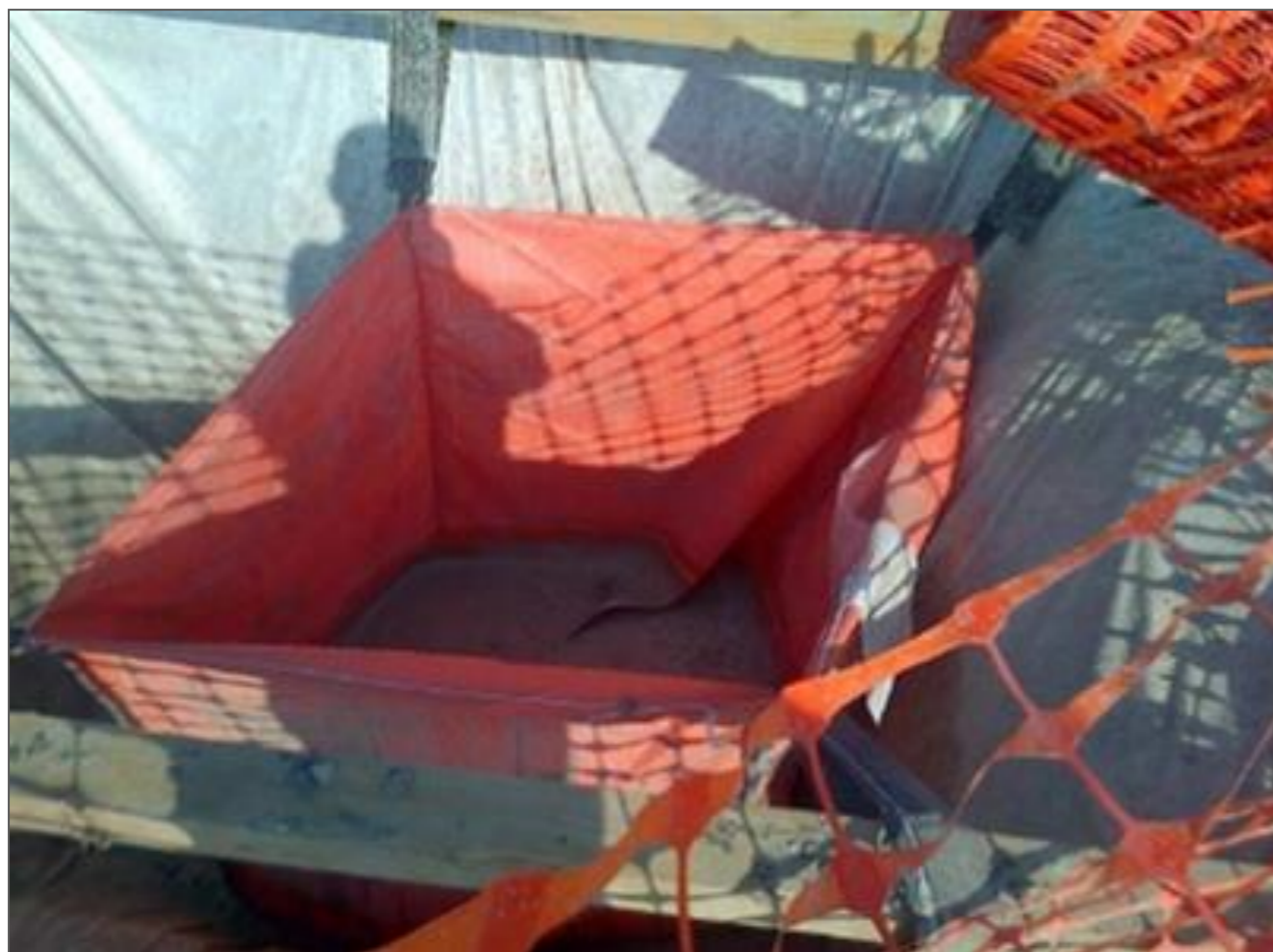
Figure 288 : Illustration photographique d'une aire de lavage des toupies
