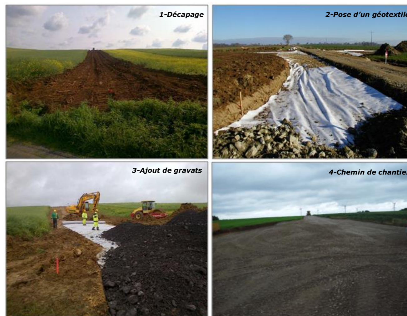
Figure 278 : Illustrations photographiques d’une construction de voirie
