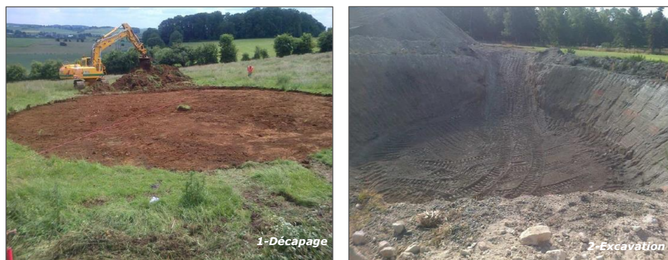
Figure 279 : Illustrations photographiques de la préparation d'une fondation
