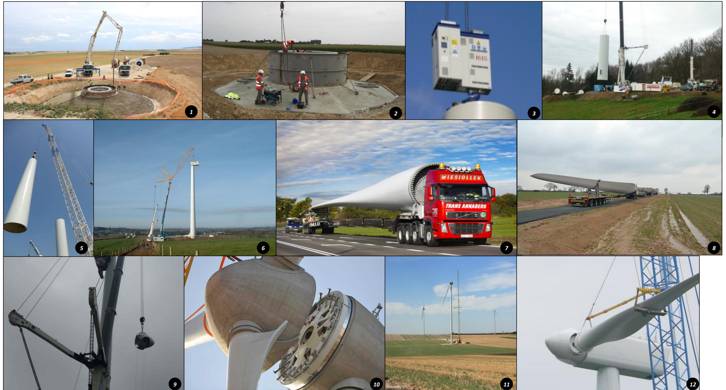
Figure 2.73 : Illustrations photographiques des phases de montage des éoliennes
