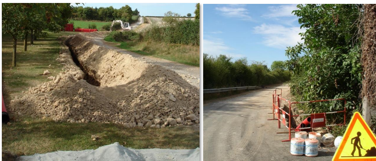
Figure 271 : Tranchée pour le raccordement au réseau local
