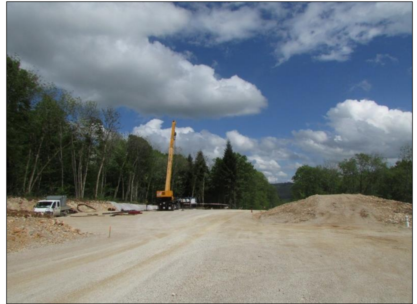
Figure 260 : illustration photographique d'une plateforme de grutage
