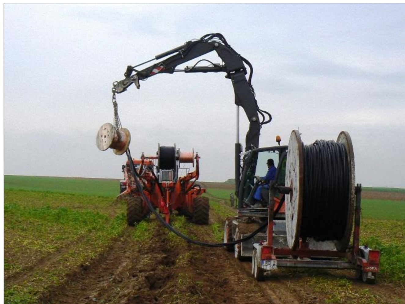
Figure 281 : Pose d'un câble HTA à 1,20 m avec la méthode du soc tracté (source VALOREM)
